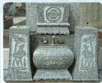
ペイントの剥がれ
